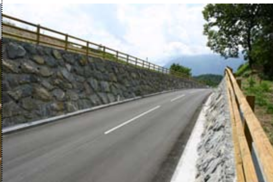
Sanacija zidov na regionalni cesti Trenta - Bovec med Kalom in Koritnico
