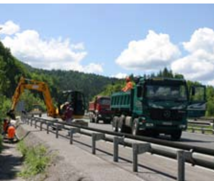
Obnova obcestnega prostora
