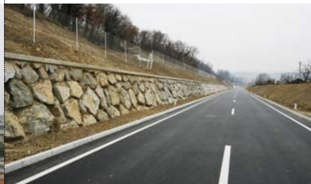
Obvoznica Solkan - podporni in oporni zidovi
