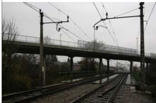
Sanacija in razširitev podvoza za železnico na regionalni cesti Ljubljana (Vič)-Brezovica
