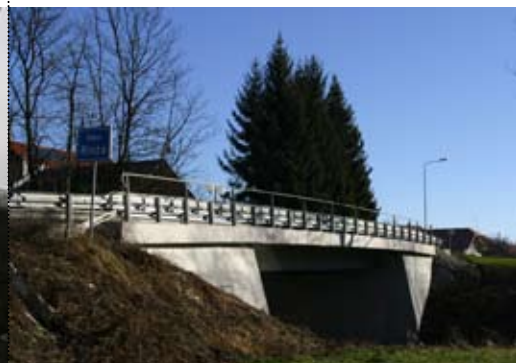
Sanacija mostu čez Rinžo
