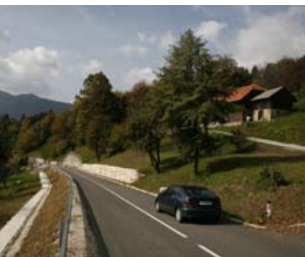
Sanacija plazov na regionalni cesti Latkova vas - Trbovlje
