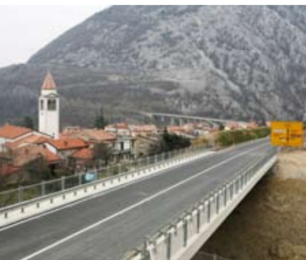
Obvoznica Solkan - viadukt
