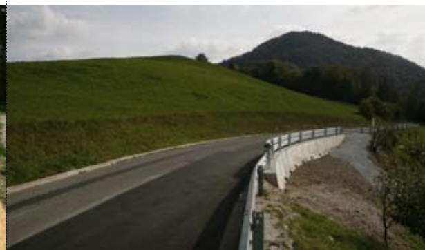
Sanacija plazov na regionalni cesti Trbovlje - Boben - Hrastnik
