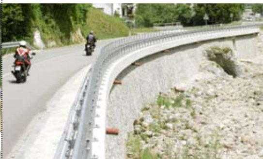
Podporni zidovi v Trebiji na regionalni cesti Trebija - Sovodenj
