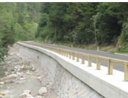
Podporni zidovi na regionalni cesti Zgornje Jezersko - Spodnje Jezersko
